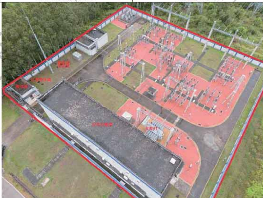
变电站航拍图
